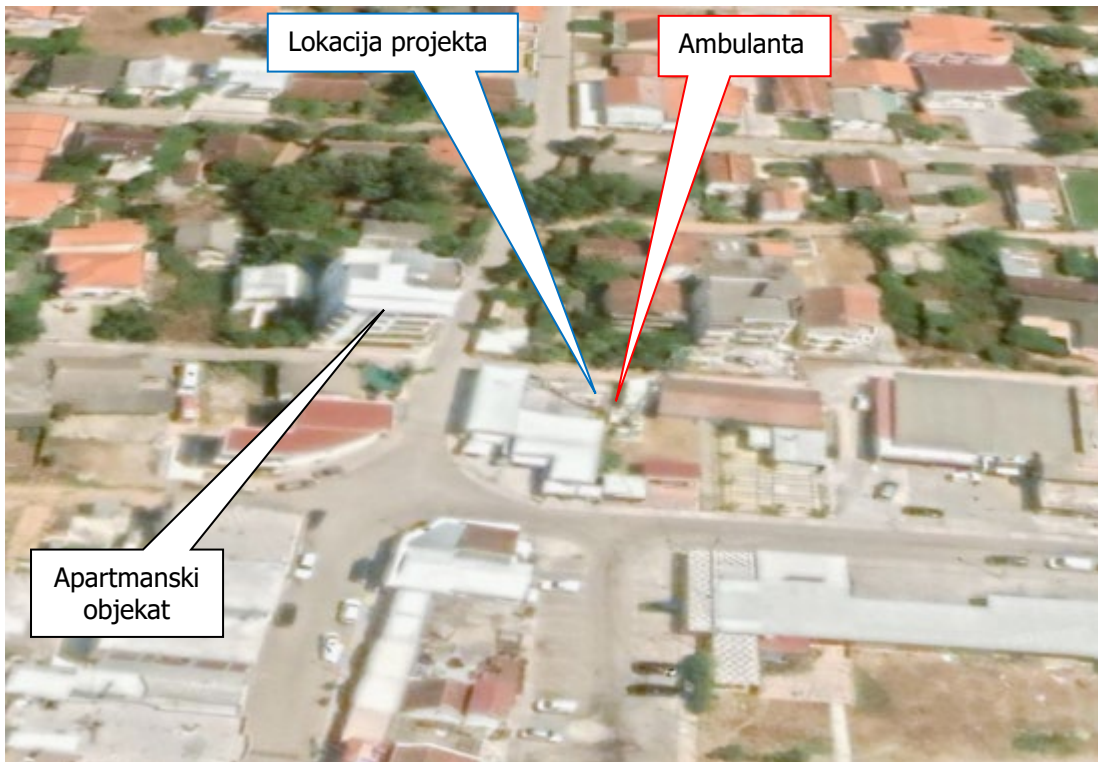
Slika 2.2. Uže okruženje bazne stanice
