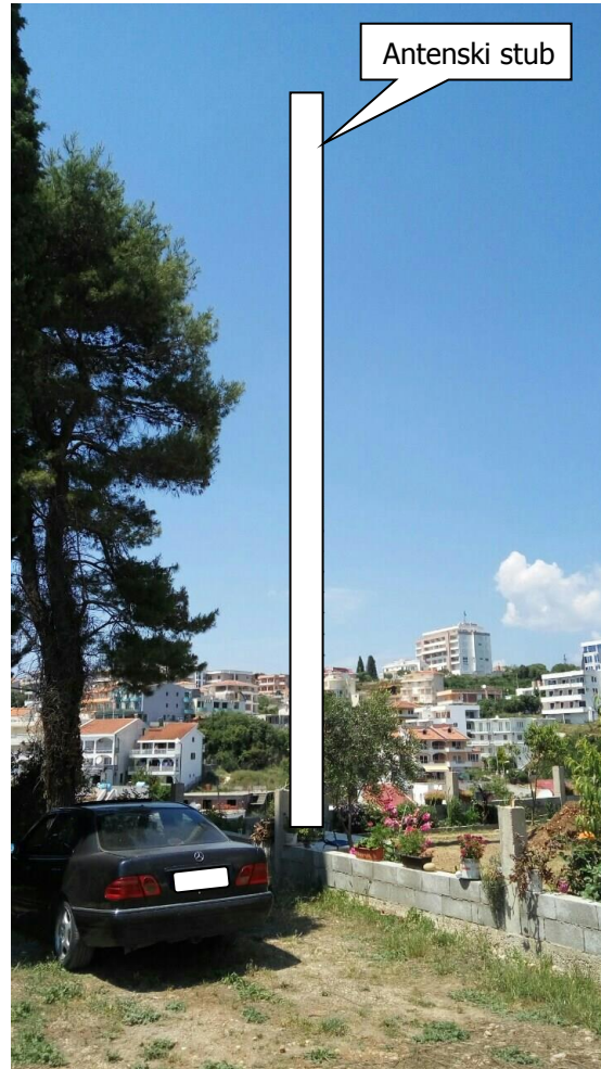
Slika 2.4. Izgled lokacije projekta sa okruženjem
